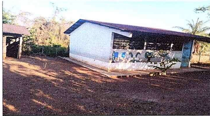
Foto 2: Mantenimiento de pintura por deterioro
