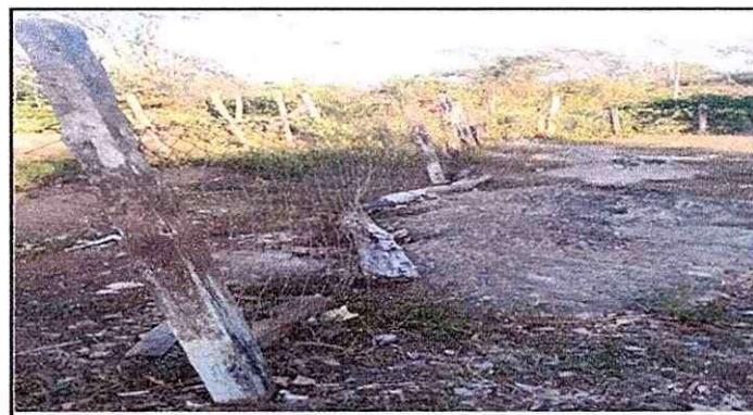
Foto 4: Mantemiento por deterioro de los postes y de malla
