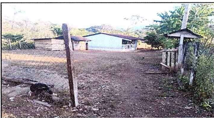
Foto 3: Mantenimiento muro perimetral por deterioro
