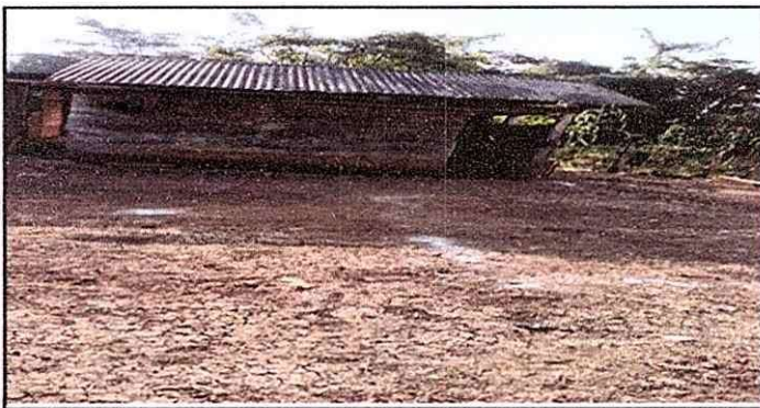
Foto 5: Construcción de cocina por mal estado
